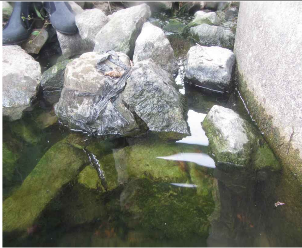
P4상행 교각 보호사석, 상태 양호
