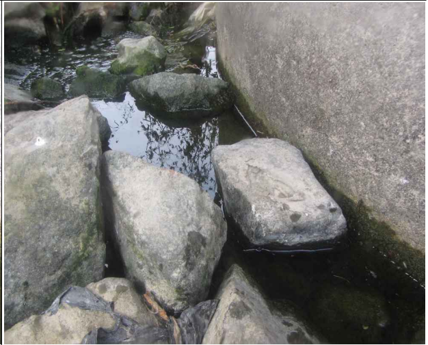
P4상행 교각 보호사석, 상태 양호
