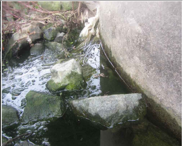
P4상행 교각 보호사석, 상태 양호
