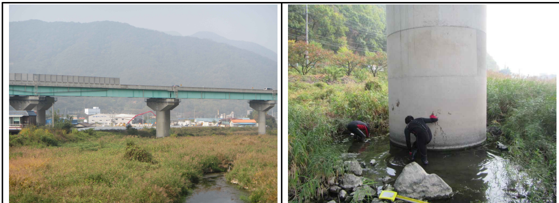
삼성1교 전경 및 조사대상 교각
