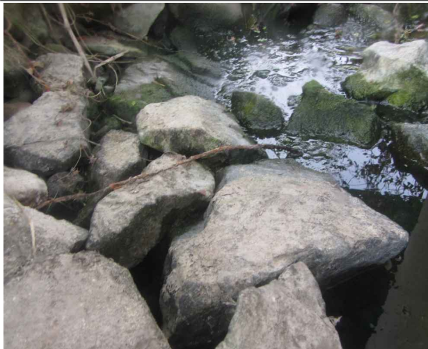
P4상행 교각 보호사석, 상태 양호
